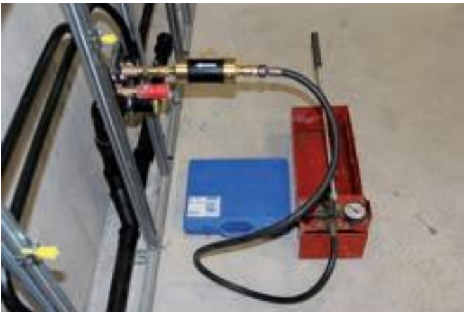
Рисунок 92: Випробувальний насос з підключеним гігієнічним фільтром Geberit
