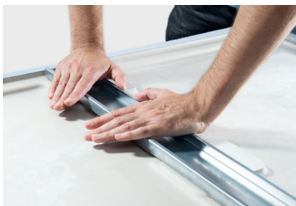
↑ Після видалення захисної плівки міцно притисніть планки, щоб приклеїти їх до нижньої сторони душової поверхні
